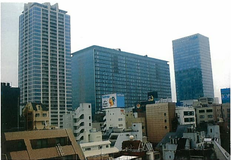
青果市場跡に建設中のクロスフィールド
