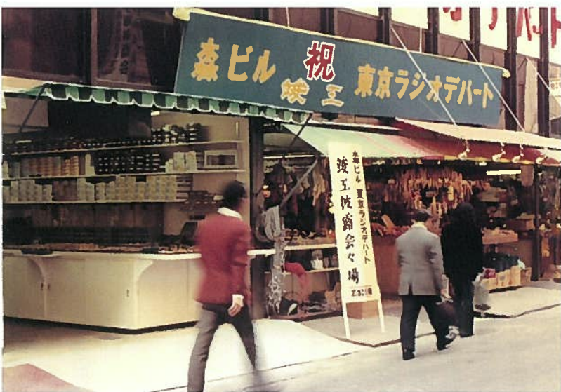
ラジオデパート竣工
